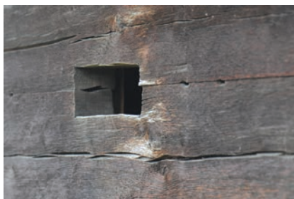
Прозорски отвор, апсида, црква брвнара Вазнесења Христовог, Прањани
