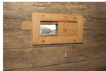
Прозорски отвор са помичним капком, унутрашња страна, црква брвнара Вазнесења Христовог, Прањани
